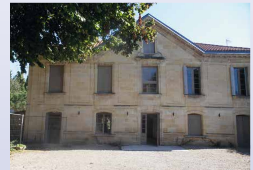
Le bâtiment principal du Collège Saint-Fort après remise en état
